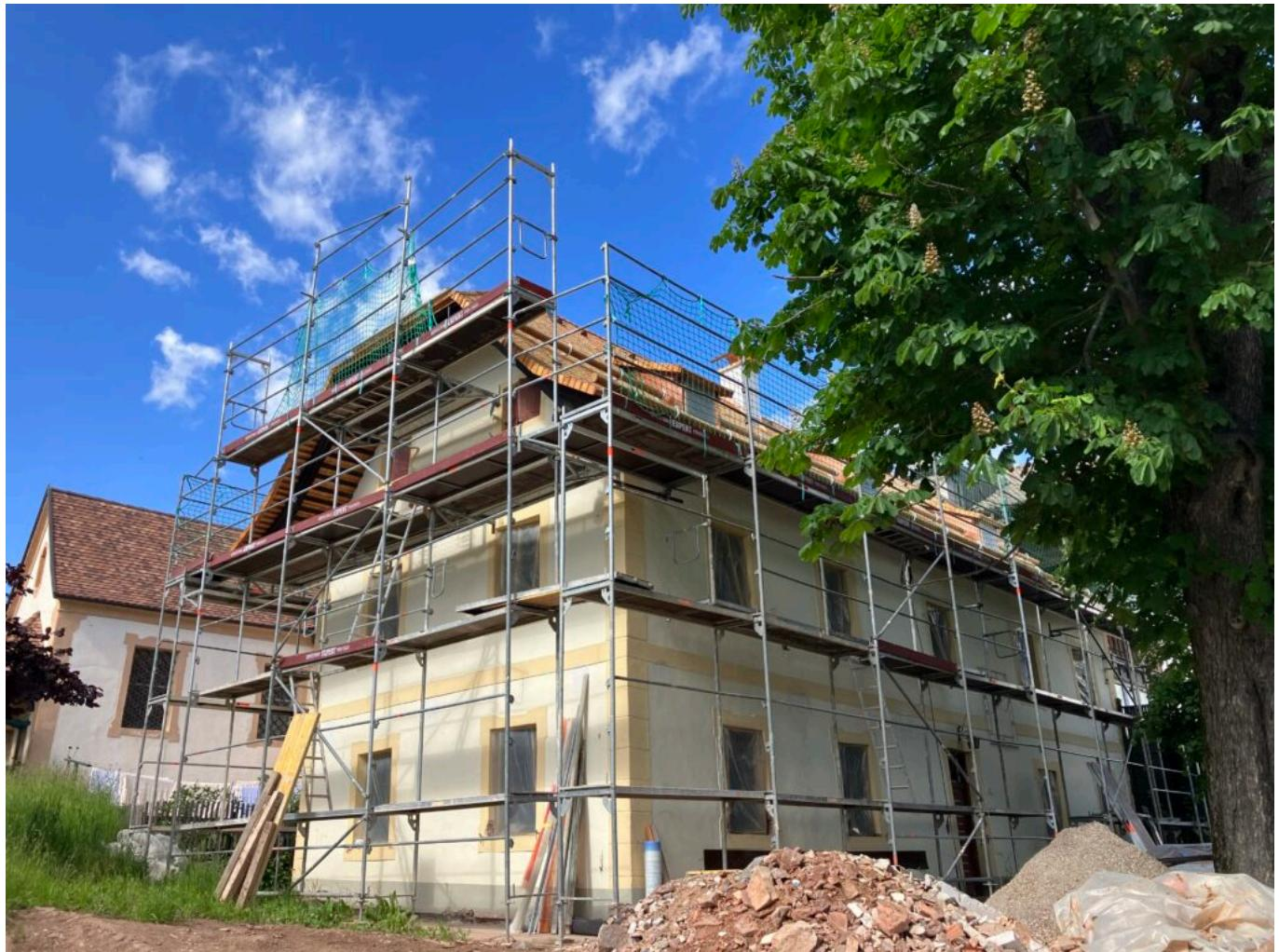
Sehr gelungen ist m.E. die Sichtbarkeit der Schindeln von unten. Trotz eines zeitgemäßer Dachaufbaus unter der Eindeckung ist alles elegant und fein und gar nicht, wie leider in vielen anderen Fällen, massiv, ja klobig, geworden. Sogar der vom original gebliebenen Dachstuhl bewirkte Knick der Struktur etwas oberhalb der Traufe, der dem Dach ein eigenes Profil gibt, kommt jetzt, wo es von der vorigen Verschalung und den Bitumenschindeln befreit wurde, besser heraus.
