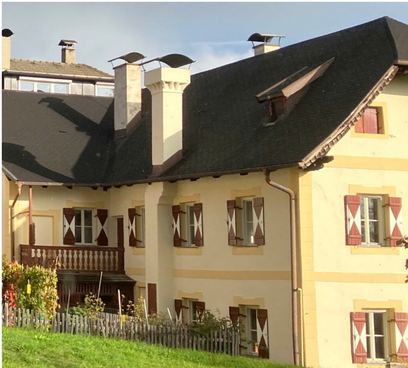
Abb. 4: Gut sichtbar der um 1900 nachträglich angebrachte Außenkamin.
