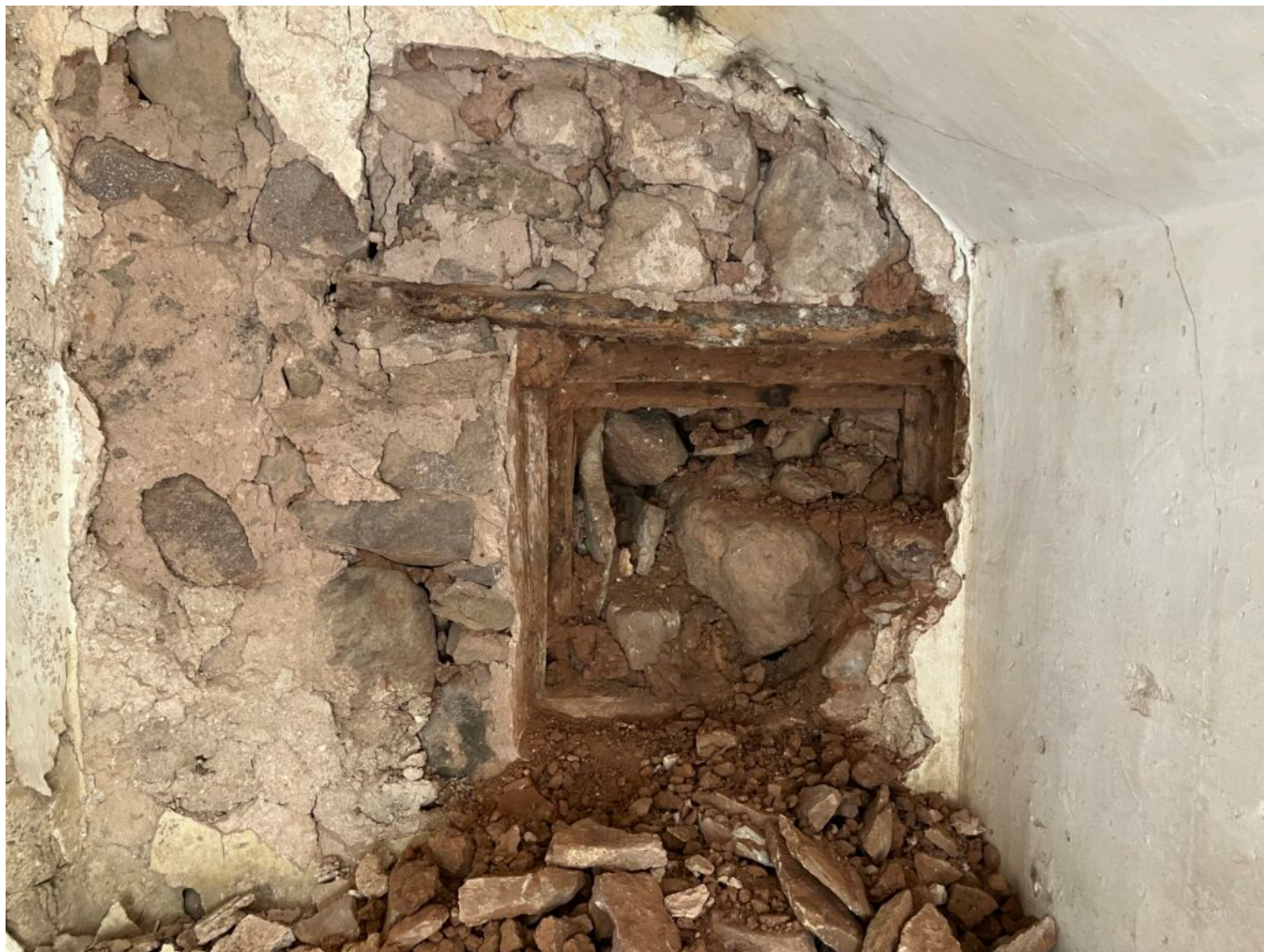
Das zugemauerte Fenster unter der Stiege (1).
