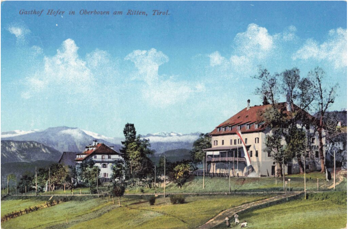
Abb. 5: Der Unterhofer, inzwischen als "Gasthof Hofer" auch Gastwirtschaft geworden (rechts) in der frühesten mir vorliegenden Abbildung vom Beginn des 20. Jahrhunderts, die Bahntrasse darunter gut erkennbar. Das massive Wohngebäude wurde gerade zum Gasthof (Hotel Hofer) umgebaut, erkennbar an der ersten Veranda nach Süden und den zahlreichen Dachgauben. Links das Wohnhaus und der Stadel des Doppelbauern.
