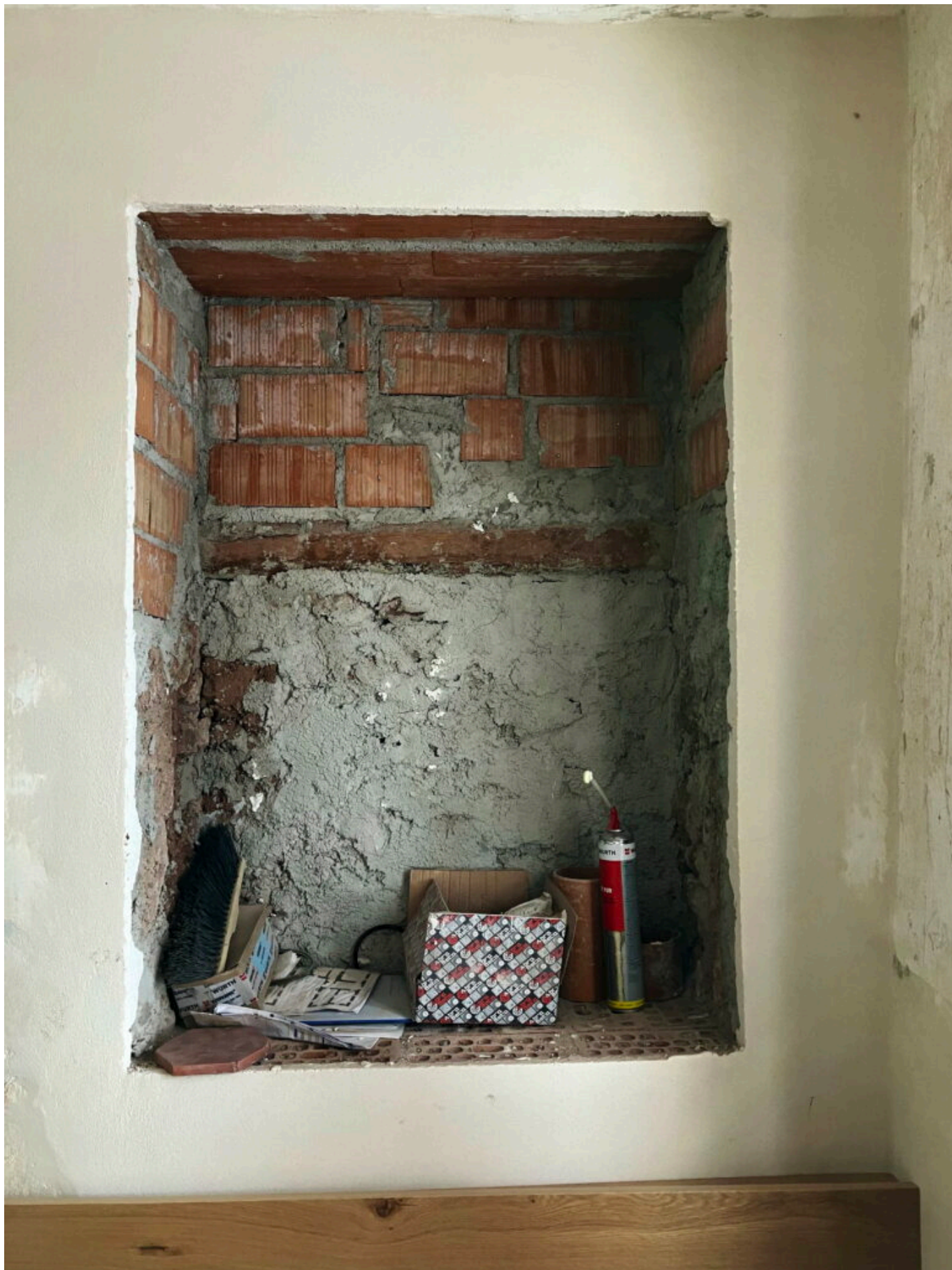
Auch hier ein zugemauertes Fenster, dies Mal in der Speis, dessen Aussparung später als Ort für einen Wandschrank genutzt wurde (3).
