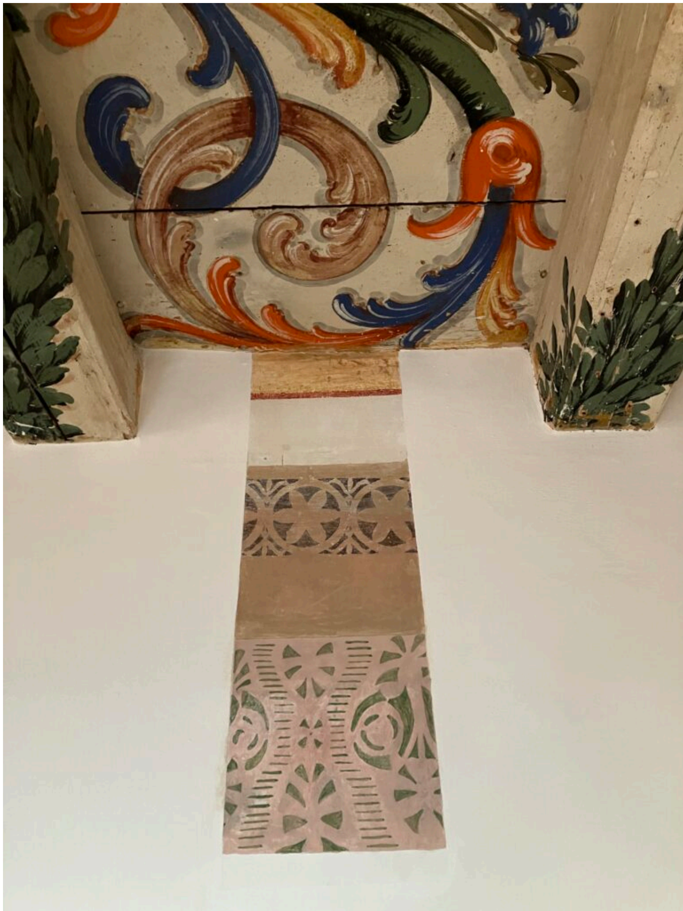
Ein sehr aussagekräftiges Fenster in die Vergangenheit, diese Farbausparung. Eine Zeitreise von oben nach unten: zuerst die barocke Deckenmalerei, dann die ockergelb und rote Umrandung der Bretter und
