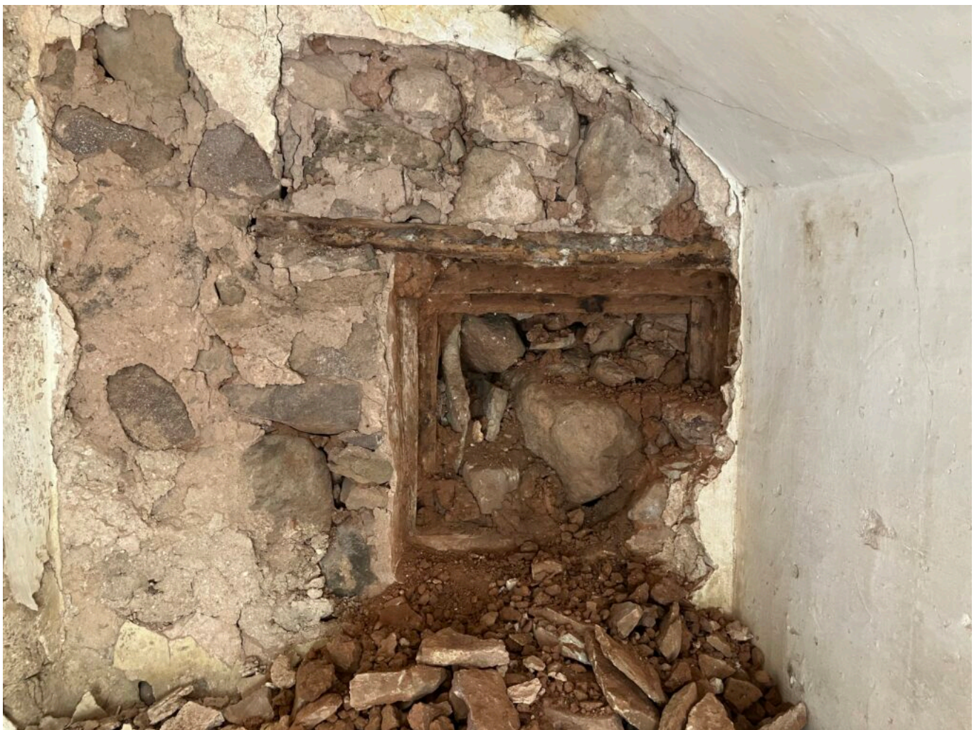
Das zugemauerte Fenster unter der Stiege (1).
