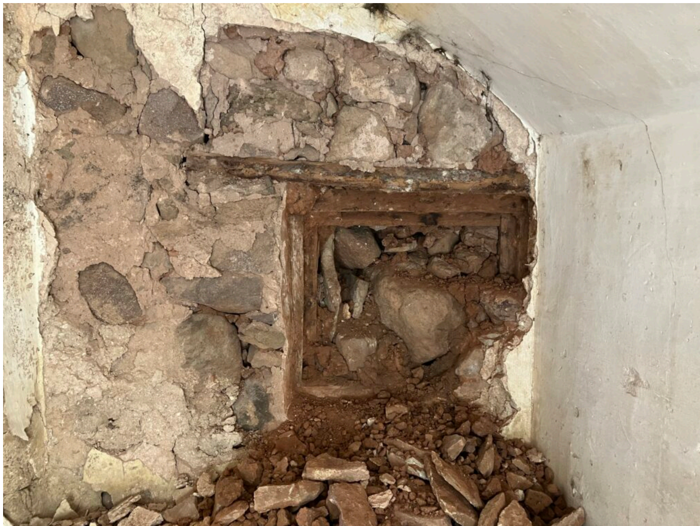
Das zugemauerte Fenster unter der Stiege (1).
