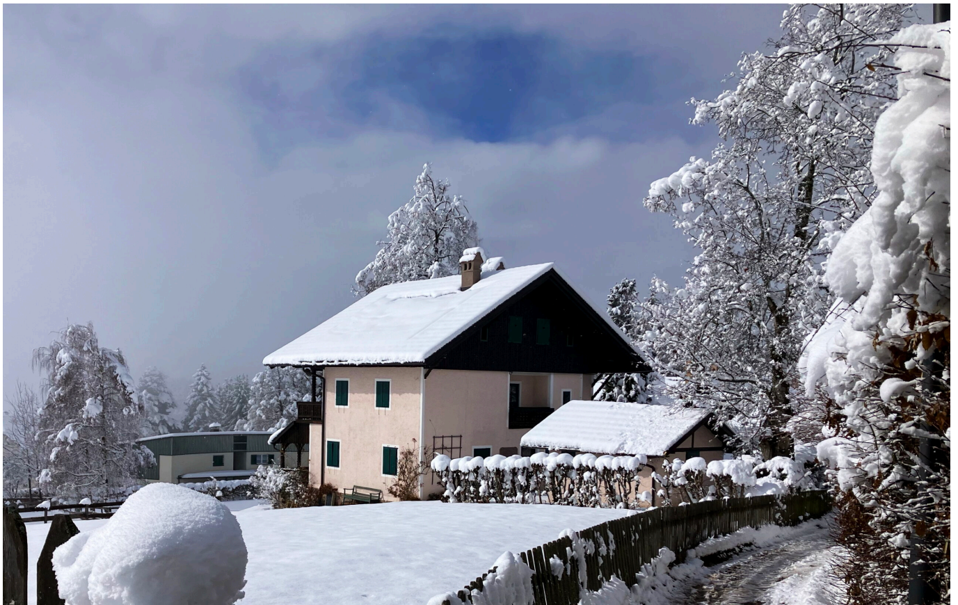
Abb. 5: Die Villa von Nordosten gesehen.
