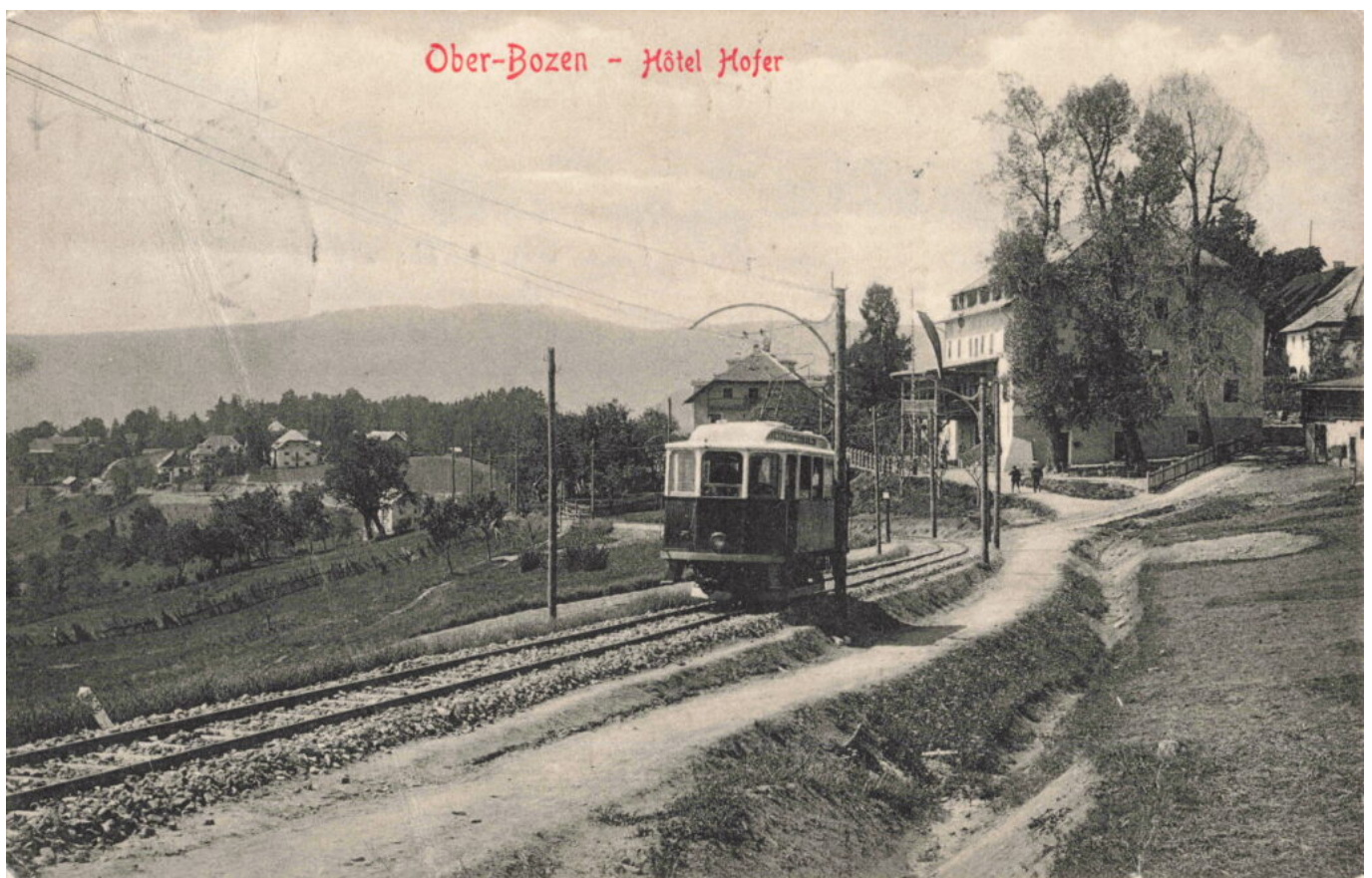
Abb. 1: "Ober-Bozen – Hôtel Hofer". Ansichtskarte aus den ersten Betriebsjahren der Rittnerbahn. Am Aufnahmeort steht heute das Café Fink. Stolz auf die Erreichbarkeit durch die Bahn, wird diese statt dem Gebäude in den Vordergrund gestellt. Rechts oben kann man, vorzugsweise wenn man das Bild durch Anklicken vergrößert, im Hintergrund das weiße Gebäude des Oberhofers und das Dach der Villa
