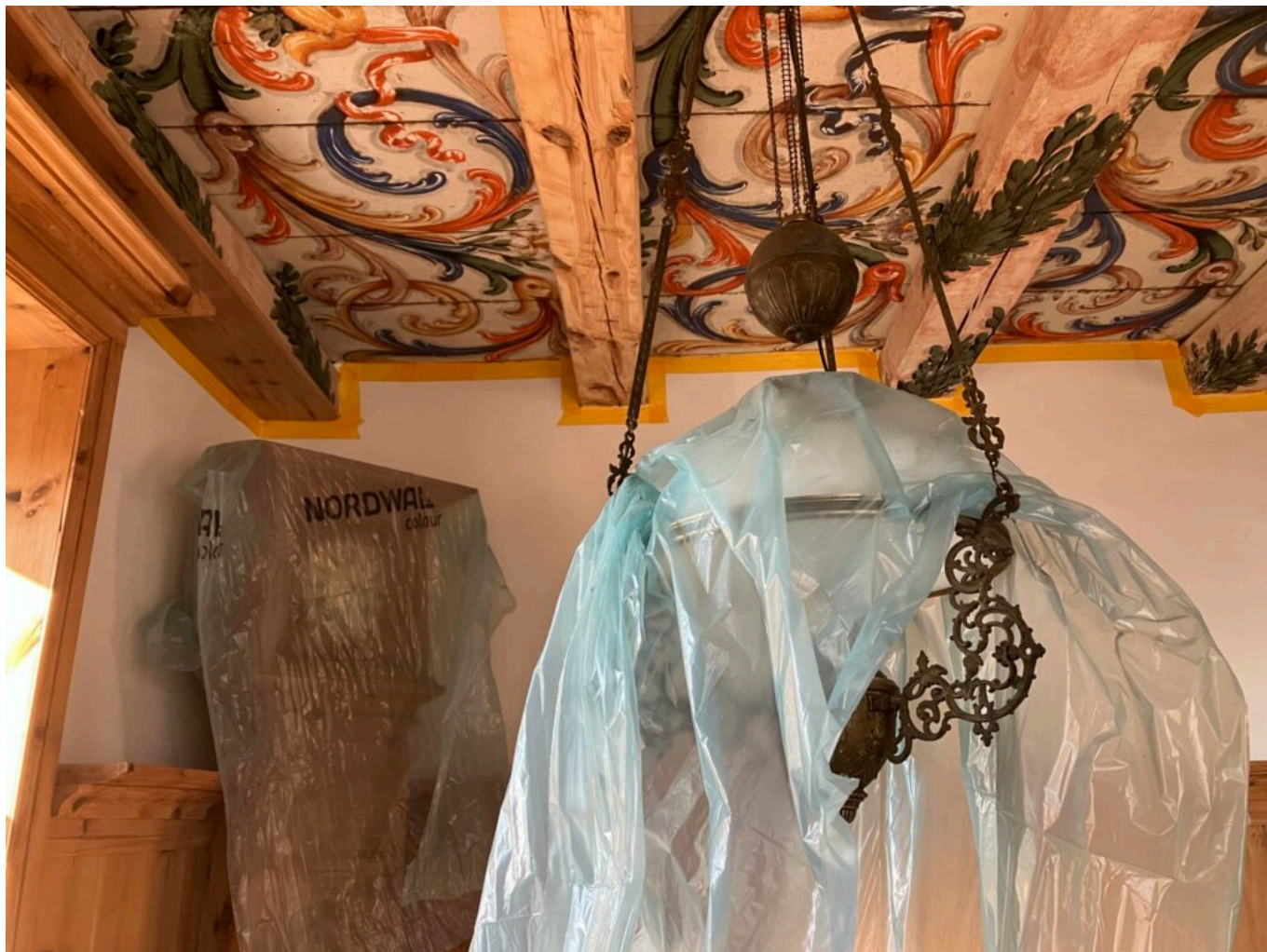
Abb. 6: Vorbeugend werden vor Beginn der eigentlichen Arbeiten die unverrückbaren Gegenstände abgedeckt. Wir befinden uns in der vorderen Stube. Links oben sieht man die Balken, die abgehobelt wurden als der Einbau der unteren Decke anstand.
