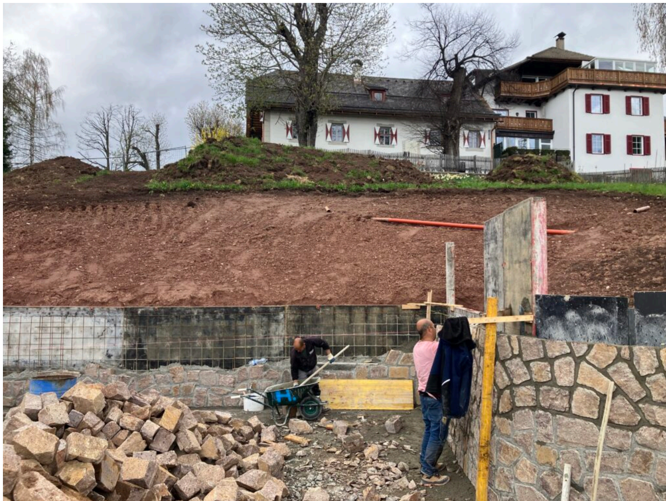
Abb. 1: Die Villa Kinsele von Süden. Im Vordergrund mittig die im Bau befindliche Parkbucht, links der Beginn des zusätzlichen Einfahrtsweges. Noch stehen keine Mauern.
