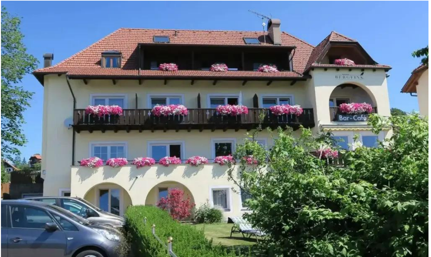
Abb. 7: Die Südseite des Hotel Bergfink. Man erkennt trotz baulicher Veränderungen die Abstammung von der Villa Maria (Foto: Manuel Benedikter Architekt).
