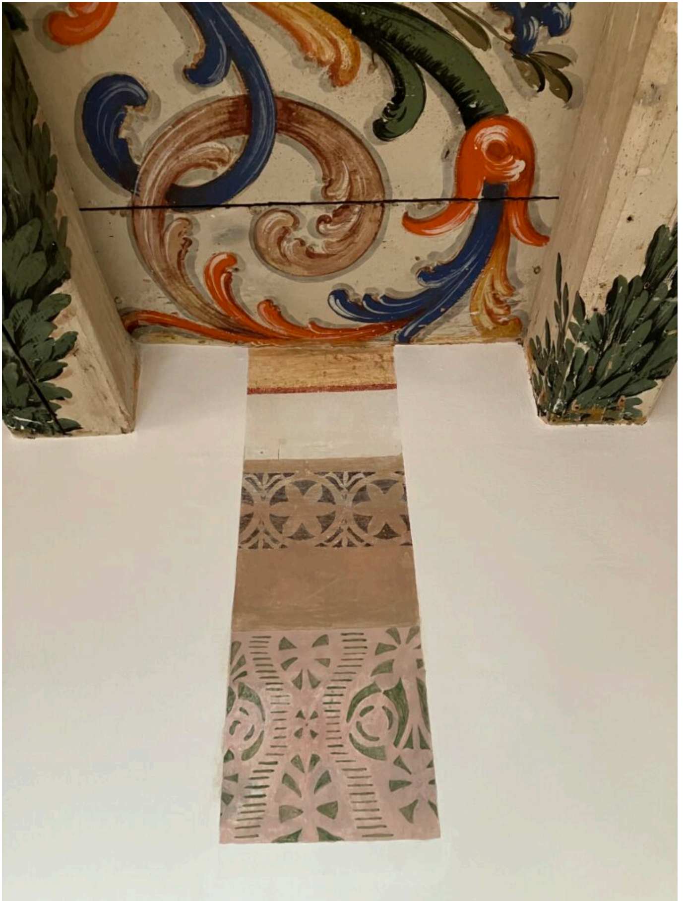
Ein sehr aussagekräftiges Fenster in die Vergangenheit, diese Farbausparung. Eine Zeitreise von oben nach unten: zuerst die barocke Deckenmalerei, dann die ockergelb und rote Umrandung der Bretter und
