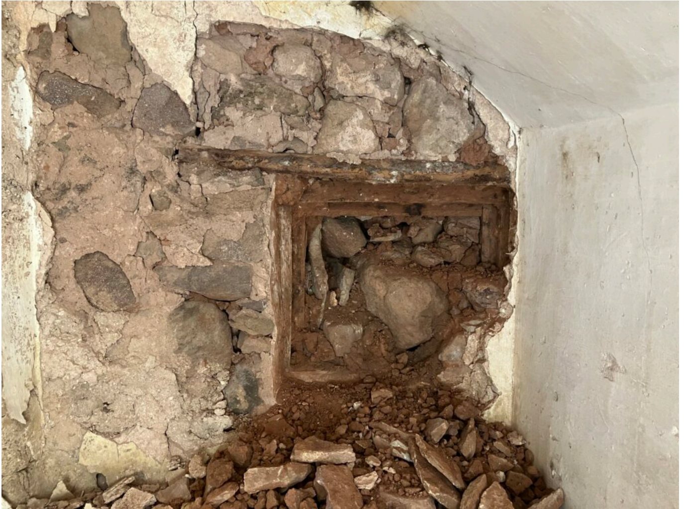
Das zugemauerte Fenster unter der Stiege (1).
