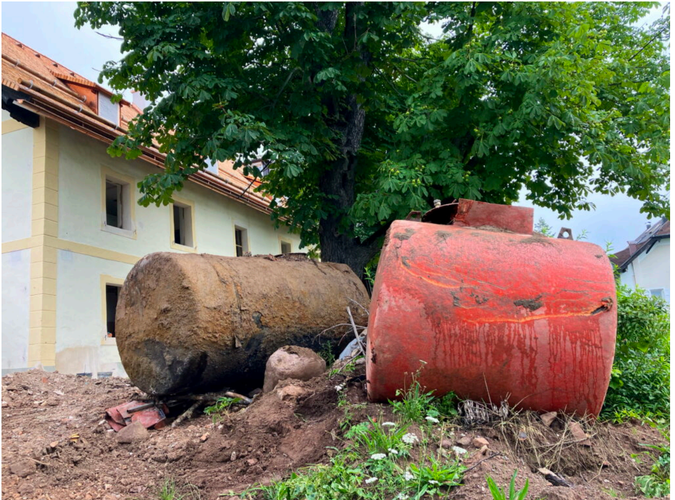
Abb. 1: Links der öltäre, aus Stahl, rechts der neuere, aus Kunststoff bestehende Heizöltank nach dem Ausgraben.
