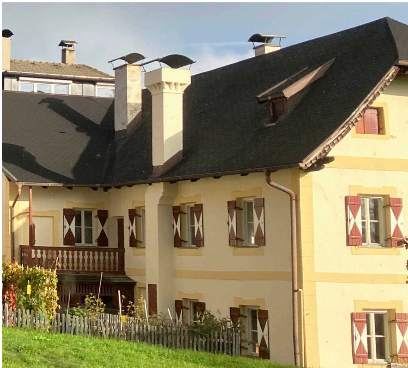
Abb. 4: Gut sichtbar der um 1900 nachträglich angebrachte Außenkamin.
