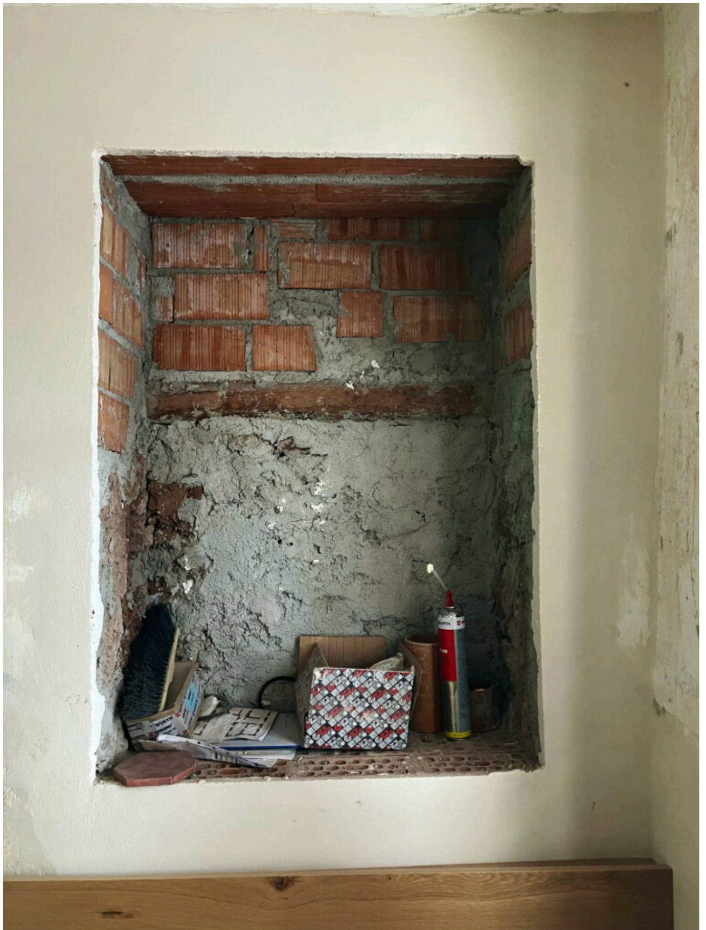
Auch hier ein zugemauertes Fenster, dies Mal in der Speis, dessen Aussparung später als Ort für einen Wandschrank genutzt wurde (3).
