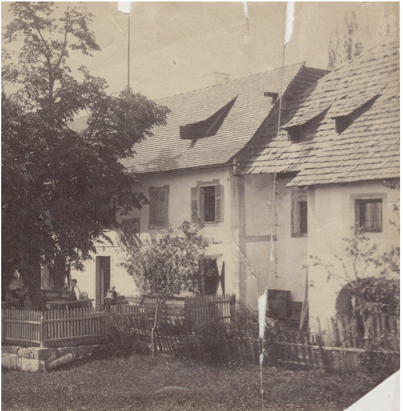
Abb. 2: Rechts ein Teil des Oberhofer-Wohngebäudes. Das rustikale
