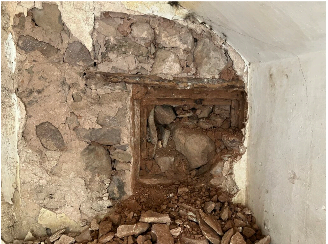
Das zugemauerte Fenster unter der Stiege (1).
