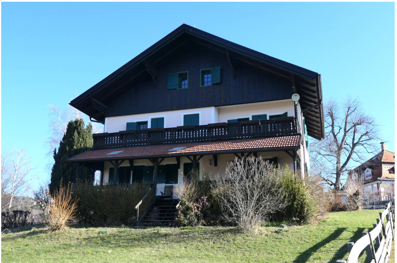
Abb. 6: Die stattliche nach Süden geöffnete Veranda und der darüber liegende großzügige Balkon prägen das Gebäude funktional und ästhetisch. Rechts im Hintergrund die Villa Pattis.
