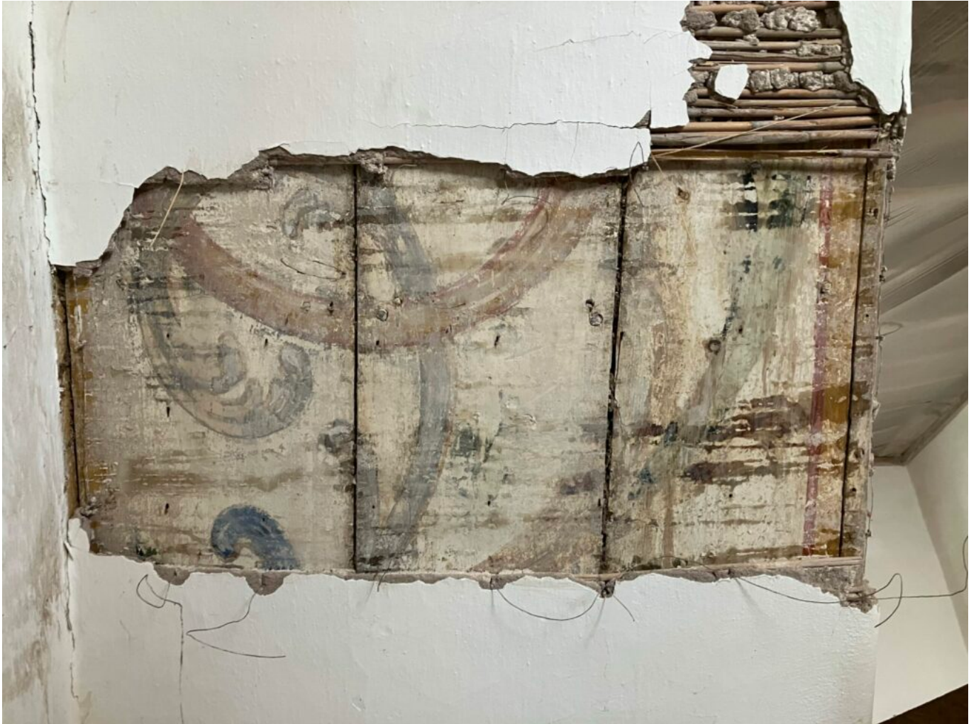
Abb. 5: Sogar die Dachbodenstiege bekam an ihrer Unterseite einen üppigen barocken Farbanstrich. Leider mussten wir hier den Verputz wieder vervollständigen, die chemische Zersetzung der Pigmente ist zu sehr fortgeschritten.
