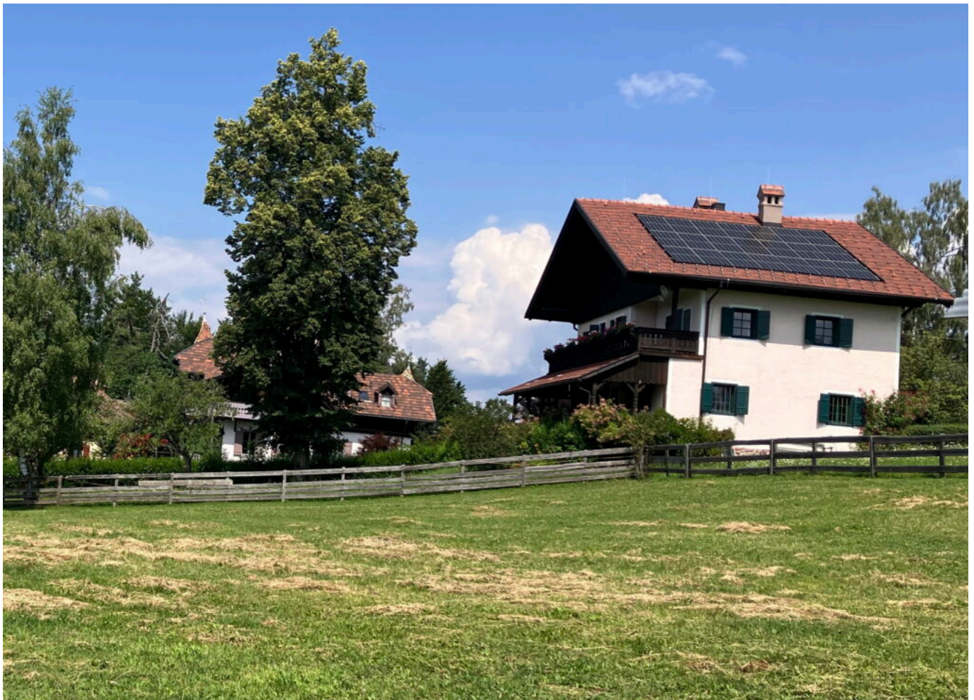
Abb. 4: Das Malinowskihaus heute nach der letztlich durchgeführten Renovierung des Daches, auf dem eine Photovoltaikanlage installiert wurde, von Osten aus gesehen. Im Wesentlichen ist das Haus über die Jahre unverändert geblieben. Links davon, halb verdeckt, das Eccel-
