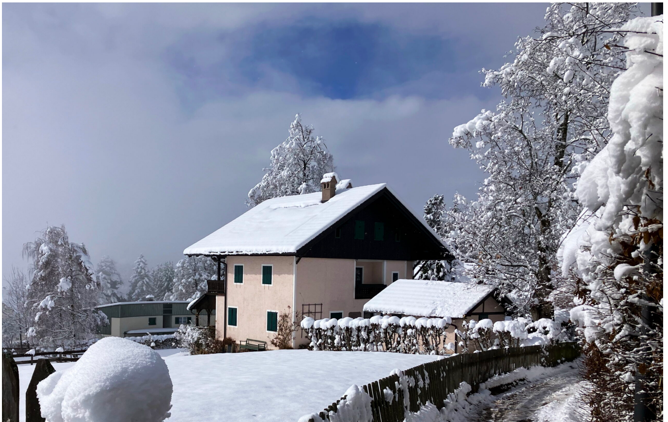
Abb. 5: Die Villa von Nordosten gesehen.
