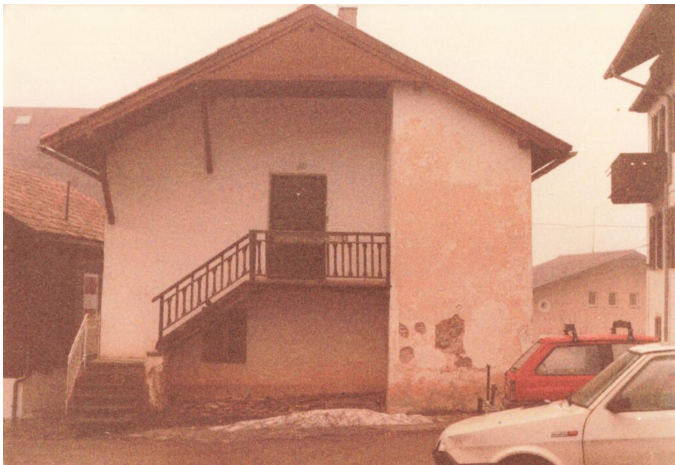
Abb. 9: Nordseite des Nebengebäudes des ehemaligen Oberhofers, Anfang der 80er Jahre. Der schwer zu findende Eingang zur ebenerdigen Raiffeisenkasse befand sich auf der Ostseite, man musste links durch den schmalen Durchgang zwischen dem Gebäude und der Dependance des Hotels Post gehen. Die Wohnung im ersten Stock wurde vermietet.
