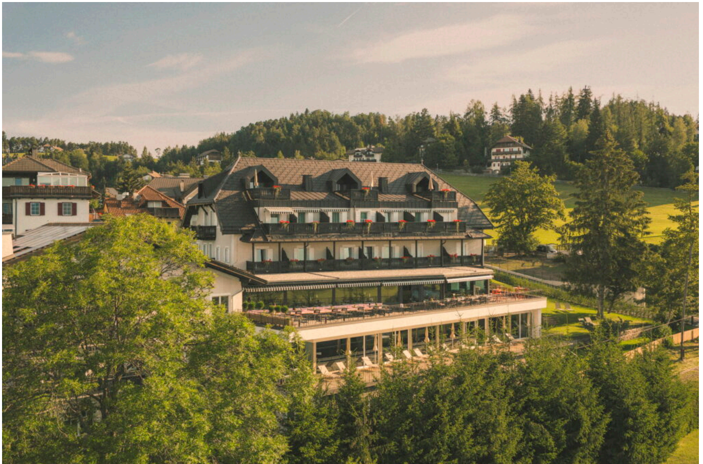
Abb. 14: Das Bella Posta Hotel im Jahre 2026 (Foto: Parkhotel Holzner GmbH).
