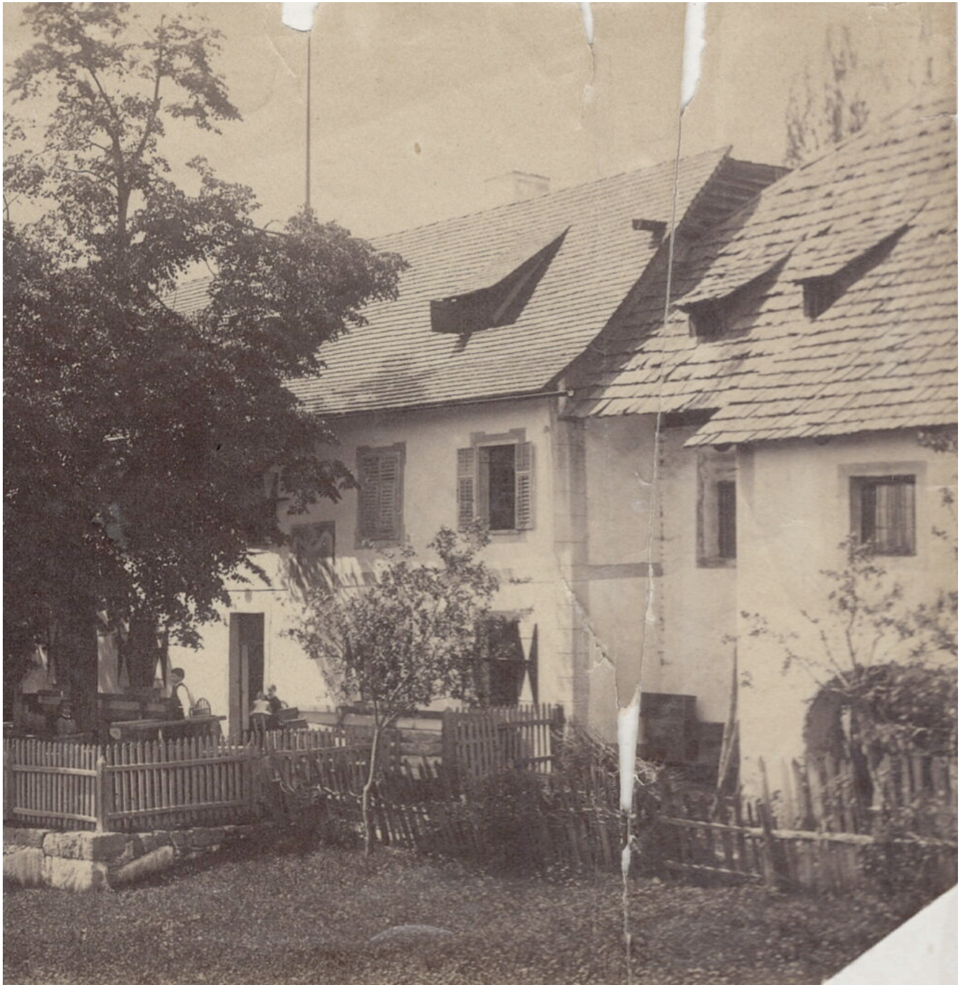
Abb. 2: Rechts ein Teil des Oberhofer-Wohngebäudes. Das rustikale Erscheinungsbild des Bauernhauses im Vergleich zur herrschaftlichen Sommerresidenz wird besonders durch die Dacheindeckung und den Bretterzaun deutlich. (Gugler, Fotografie um 1900). Klicken Sie wie
