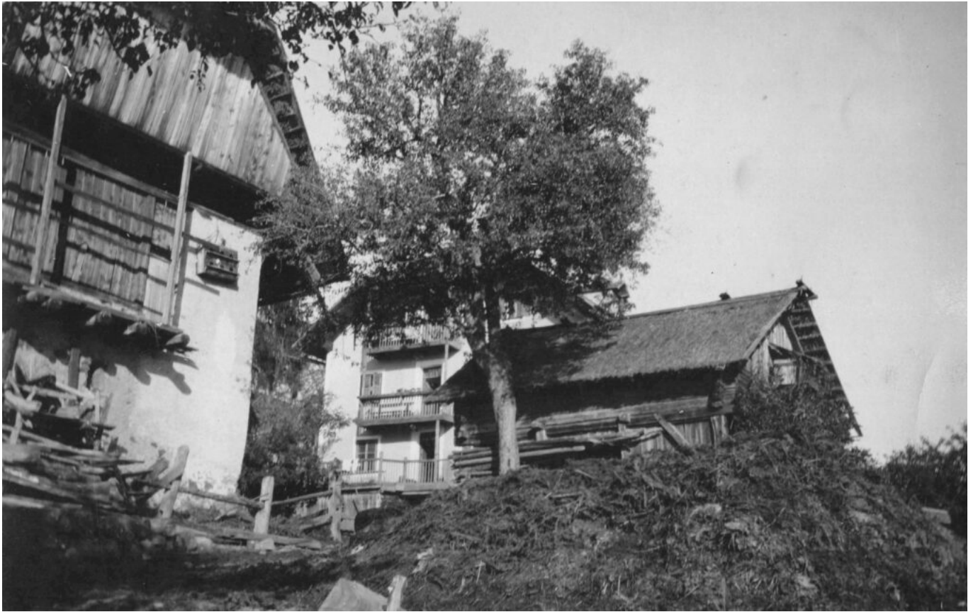
Abb. 8: Von vorne nach hinten: Stadel, Neben- und Wohngebäude des Doppelbauernhofes um die vorletzte Jahrhundertwende (Foto, Sammlung Kinsele-Kobler).
