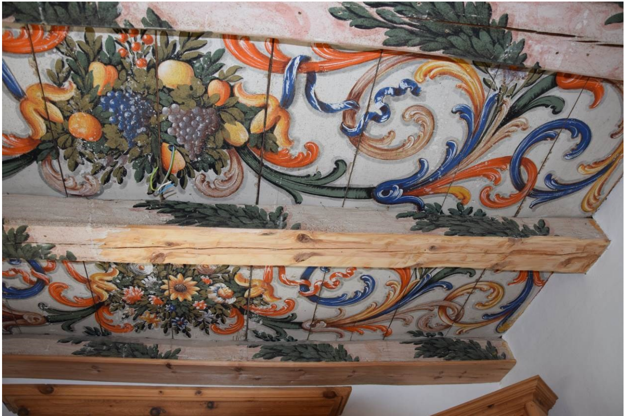
Fehlstellen durch abgehobelte Balken
