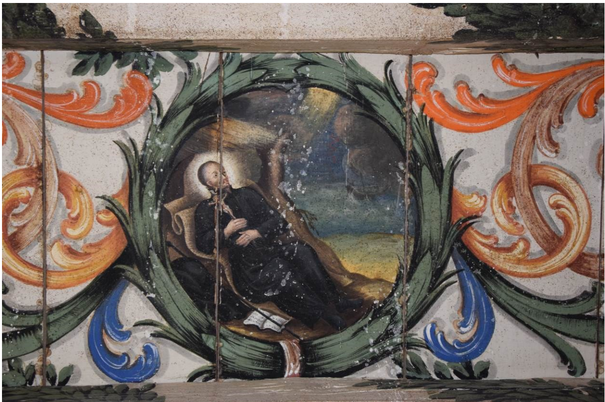
Verunreinigung durch Kalkspritzer an der Malerei
