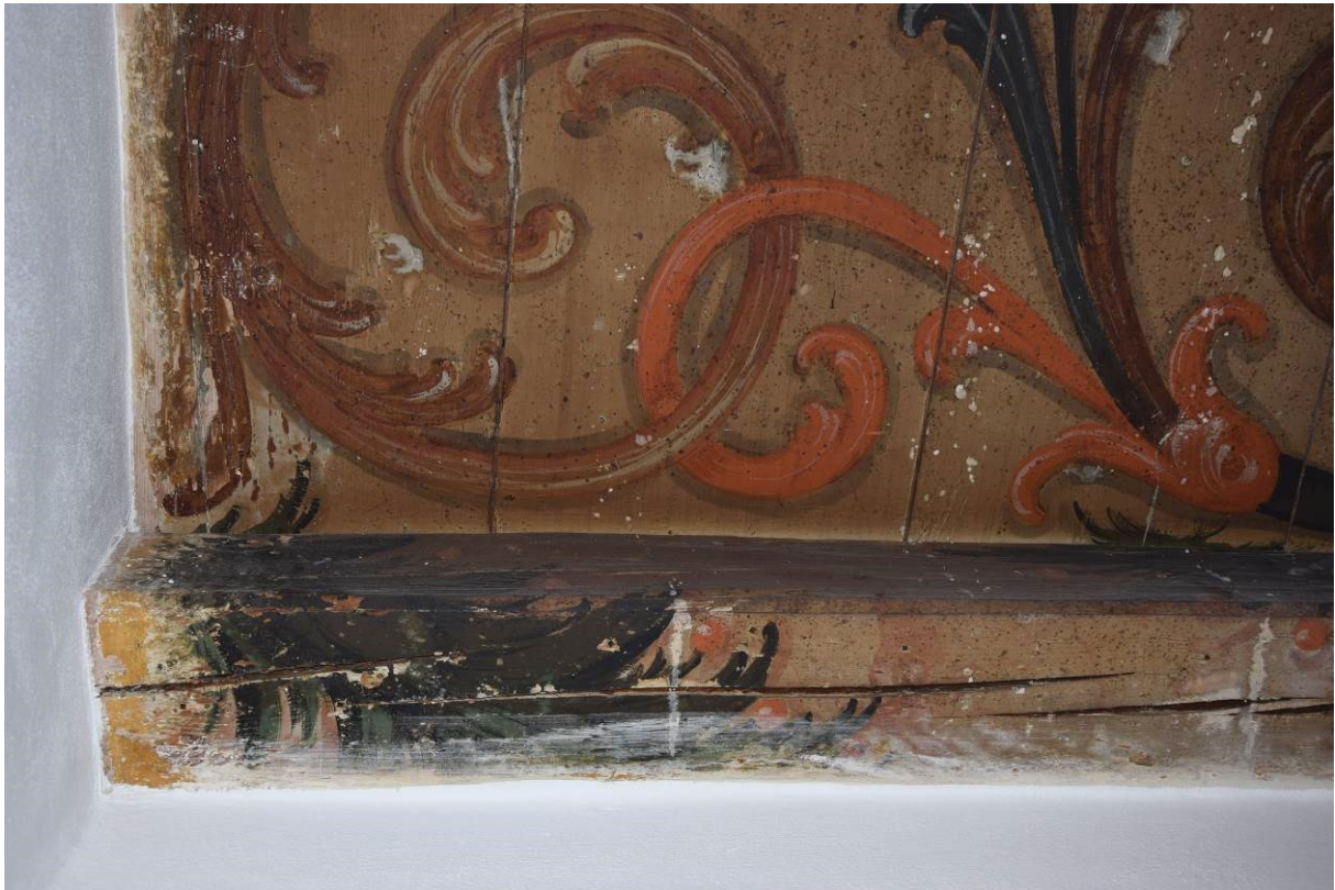
Schäden und Verunreinigungen mit Mörtel und Farbe am Rand der Decke, die durch Bautätigkeit verursacht wurden
